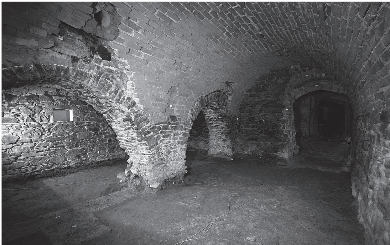
Abb. 8 Troppau – Zwischen Märkten 2. Blick in das Interieur einer mittelalterlichen Kammer (14. Jh.) mit einer sekundär angelegten Arkadenmauer (1. Hälfte des 15. Jh.) und einer Wölbung (2. Hälfte des 15. Jh.); im Hintergrund ein nachträglich durchgebrochener Zutritt zu den Kellern in der Front der Parzelle (Photo F. Kolář, 2010).
