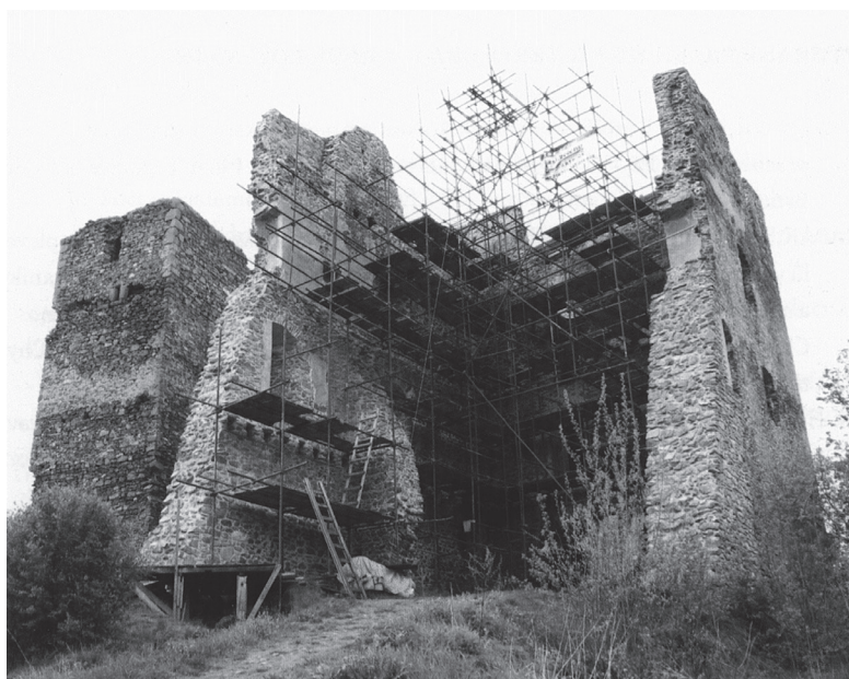
Abb. 6 Hrad Burg Rokstein, Katastergelbiet P. Lhota, Stadt Pirnitz. Oberer Palast und Turm in den Jahren 2005–2007 während der Restaurierung und Stabilisierung des Mauerwerks. Nach: Ž. Měřínský 2007 ; Foto: S. Jirků.
