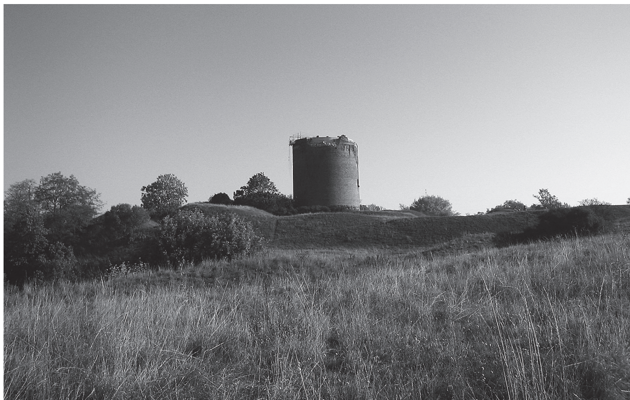
Abb. 2 Stolpe, Burgturm, Überblick gg. NO (Foto: Schütz 2006).
