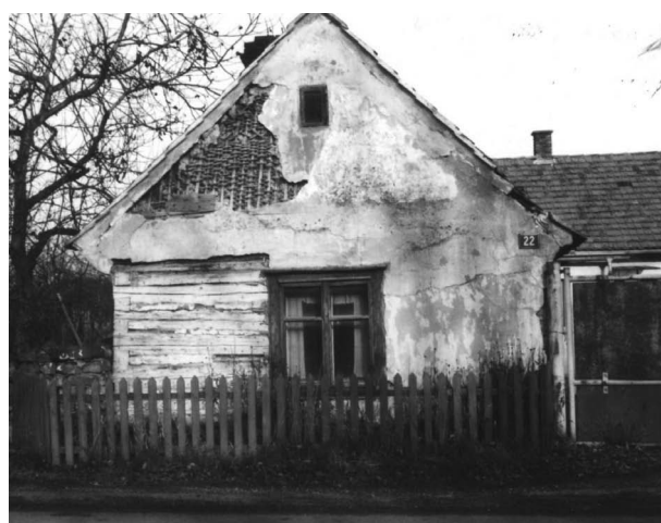
Obr. 124 Osovec, okr. Beroun, čp. 22: vyplétaný štít roubeného stavení. Foto Z. Sklenářová 1994. – Abb. 124 Osovec, Bez. Beroun, Konstr.-Nr. 22: der ausgeflochtene Giebel eines Blockhauses. Aufnahme Z. Sklenářová 1994.
