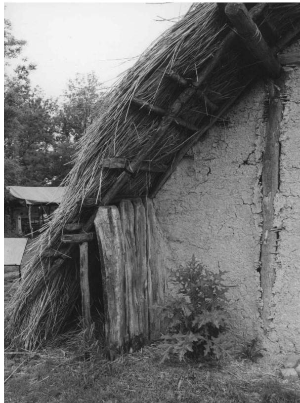
Obr. 34 Palisádová stěna v experimentální rekonstrukci neolitického domu: Březno u Loun (I. Pleinerová a kol.; archeoskansens – Oblastní muzeum v Lounech). Foto Z. Sklenářová 2004. – Abb. 34 Die Palisadenwand in experimenteller Rekonstruktion des jungneolithischen Hauses: Březno bei Louny (I. Pleinerová und Koll., Archäopark beim Bezirksmuseum Louny). Aufnahme Z. Sklenářová 2004.
