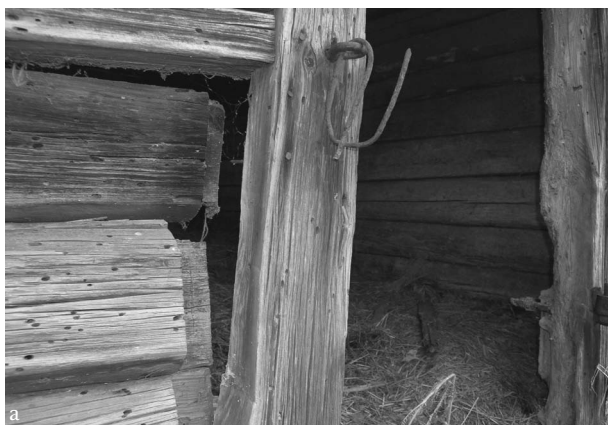
Obr. 30 Vysoká u Kosovy Hory-Dobrohošť, okr. Příbram, seník u čp. 2. Drážková konstrukce v místě spojení roubené stěny s ostěním dveří – opracované konce trámů v destruovaném místě: a – pohled zevně, b – pohled zevnitř. Foto Z. Sklenářová 2004. – Abb. 30 Vysoká u Kosovy Hory-Dobrohošť, Bez. Příbram, Heuscheune beim Anwesen Konstr.-Nr. 2. Pfosten-Nut-Konstruktion im Verband der Blockwand mit dem Türpfosten – die gezimmerten Balkenenden im eingestürzten Punkt. Aufnahme Z. Sklenářová 2004.
